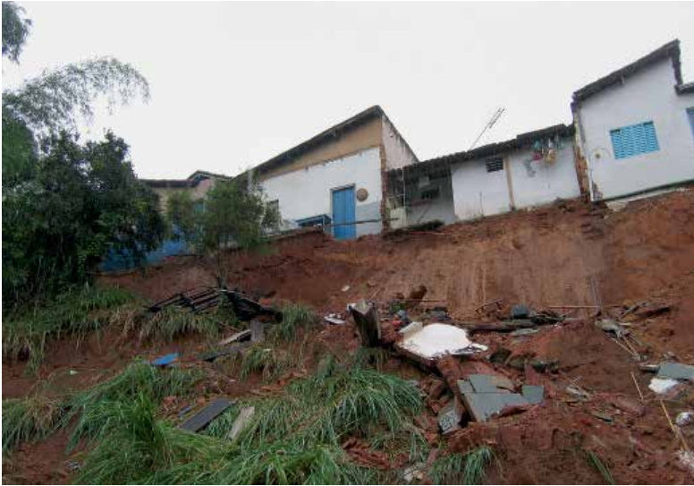
FIGURA 2 – OCUPAÇÃO EM ÁREA DE RISCO.
