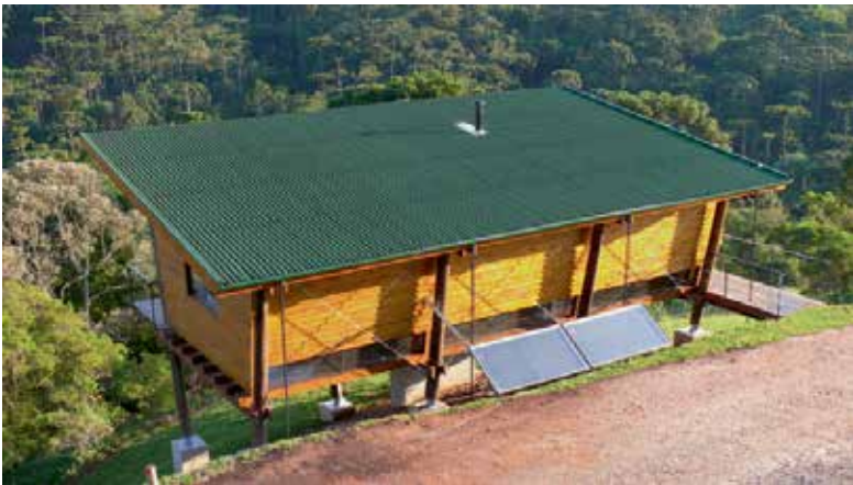
FIGURA32–UTILIZAÇÃO DE COLETORES SOLARES PARA AQUECIMENTO DA ÁGUA.FONTE:ANDRÉ EISENLOHR
