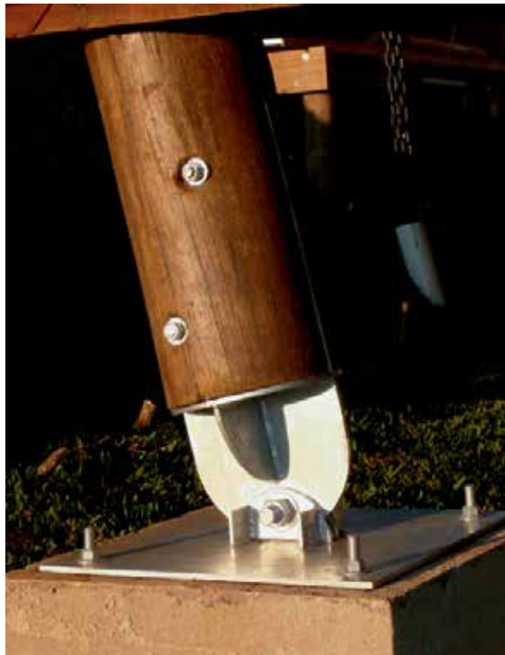
FIGURA33–PILARESDESUSTENTAÇÃOCOMMADERASDEREFLORESTAMENTO.FONTE:ANDRÉ EISENLOHR
