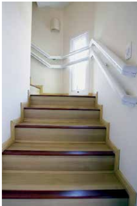
FIGURA 28 – ESCADAS COM CORRIMÃO E SENSORES DE PRESENÇA PARA ILUMINAÇÃO. FONTE: MARCONDES PERITO ENGENHARIA E ARQUITETURA
