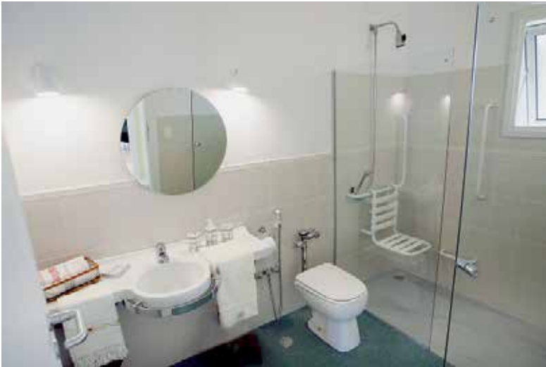
FIGURA30—BANHEIRO COM BARRA E CADEIRA DE APOIO. FONTE: MARCONDES PERITO ENGENHARIA E ARQUITETURA
