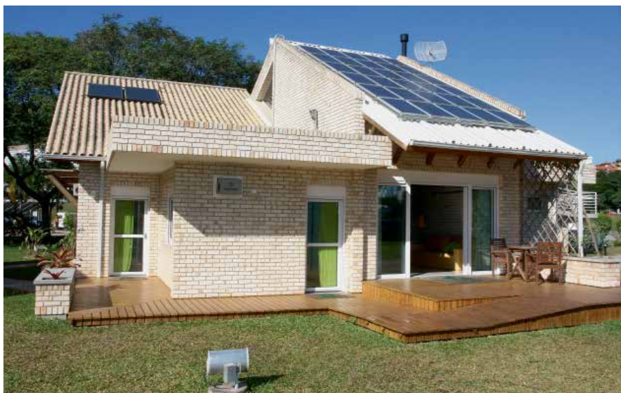
FIGURA9–(A)PLACASFOTOVOLTAICAS.(B)PLACASFOTOVOLTAICASINSTALADASNA“CASAEFICIENTE”PROJETOEM PARCERIA COM A UFSC/LABEEE E A ELETROBRÁS (AUTORIA: ANÍSIO ELIAS BORGES).
