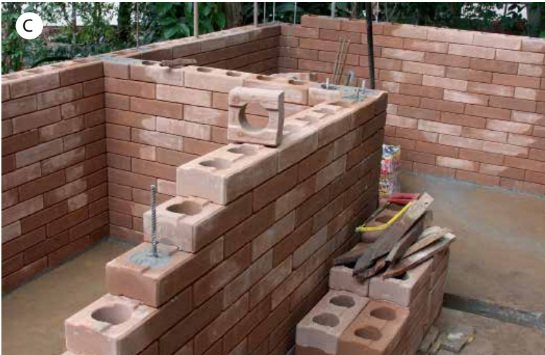
FIGURA 21 – (A) OS PISOS INTERTRAVADOS EVITAM A IMPERMEABILIZAÇÃO DO SOLO, POIS PERMITEM O ESCOAMENTO DAS ÁGUAS. (B) E (C) TIJOLOS DE SOLO-CIMENTO FABRICADOS COM 95% DE TERRA E 5% DE CIMENTO QUE REQUER POUCA ARGAMASSA (SISTEMA DE ENCAIXE) E GERAM POUCOS RESÍDUOS NA OBRA. FONTE: ACERVO SMA.
