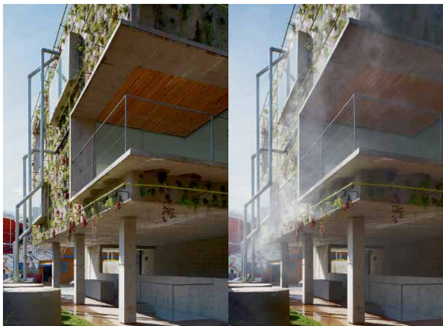
FIGURA 37 – FACHADAS COM VEGETAÇÃO LOCAL E IRRIGAÇÃO POR TUBULAÇÕES QUERODEIAMA EDIFICAÇÃO GARANTEM O CONFORTO TÉRMICO DOS SEUS OCUPANTES. (FONTE: TRIPTYQUE ARQUITETURA)
