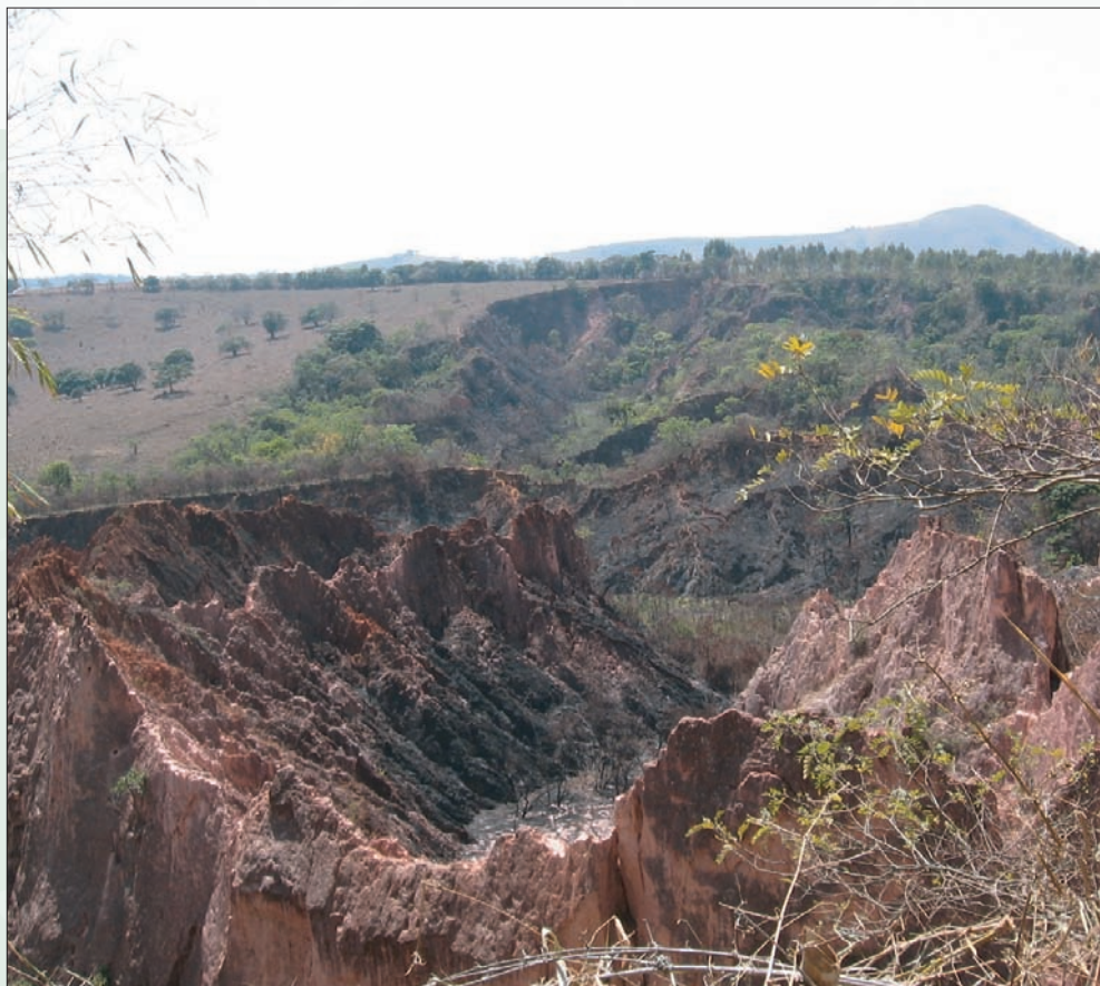
Processo erosivo causado pela má utilização do solo
