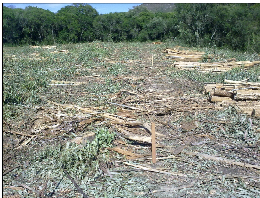
Figura 70 – Aspecto do solo após as sucessivas passadas das máquinas.
