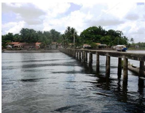
Figura 16: Ponte do atracadouro da comunidade de Ponta
