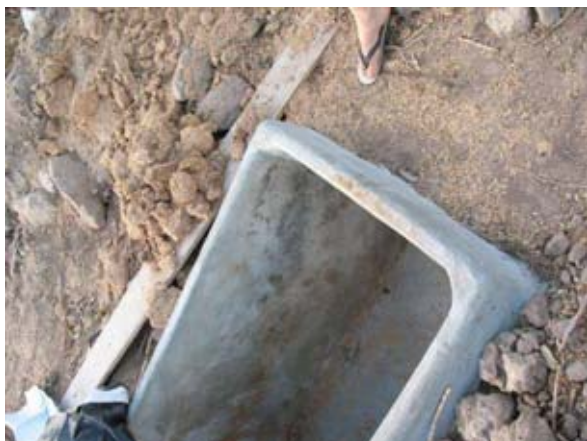
Foto 2.2: Silo subterrâneo familiar
