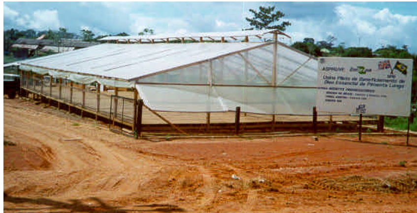
FIG. 1. Secador solar de biomassa de pimenta longa.
