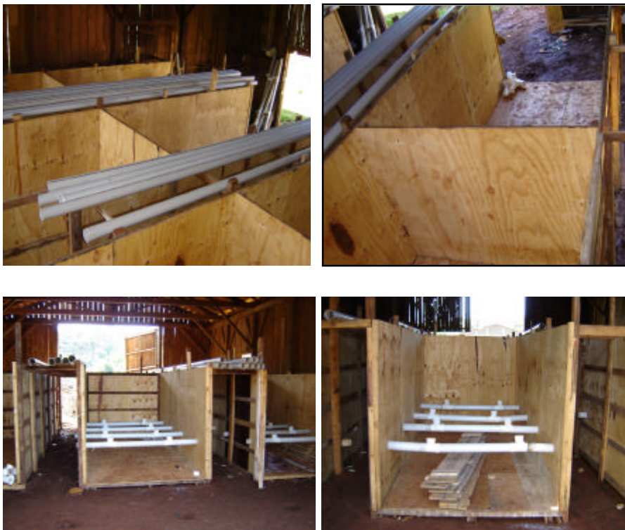
Figura 2. Detalhes da construção dos módulos de compostagem com opção de paredes e fundo em compensado. Observar materiais como os tubos plásticos para o sistema de ventilação e as tábuas para fechamento dos módulos
