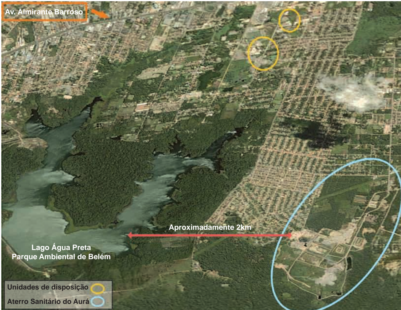
Figura 13. Localização do aterro e lixões próximos ao sistema de abastecimento de água do Utinga (Fonte: Google Earth ).
