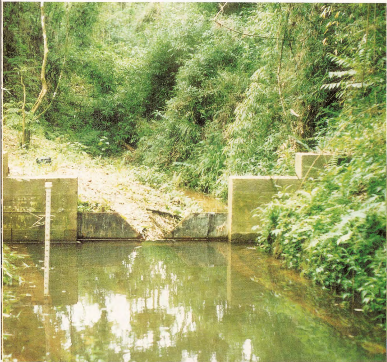
Barragem construída para estudo de microbacia na região de Arapoti (PR)
