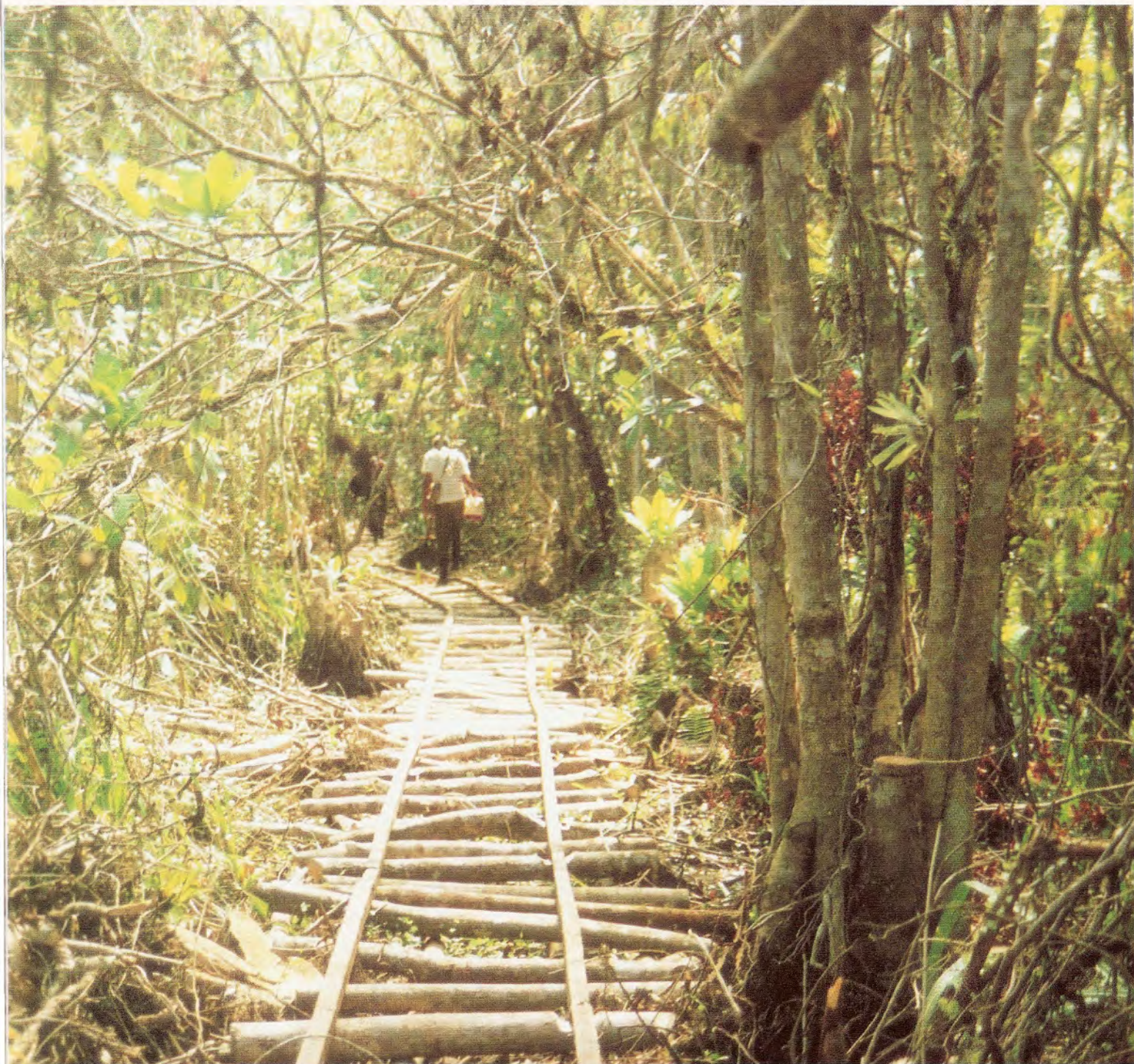
Trilhos do vagonete usado para retirada da madeira de caixeta ( Tabebuia cassinoides ) no interior da floresta, na região do Vale do Ribeira (SP)
