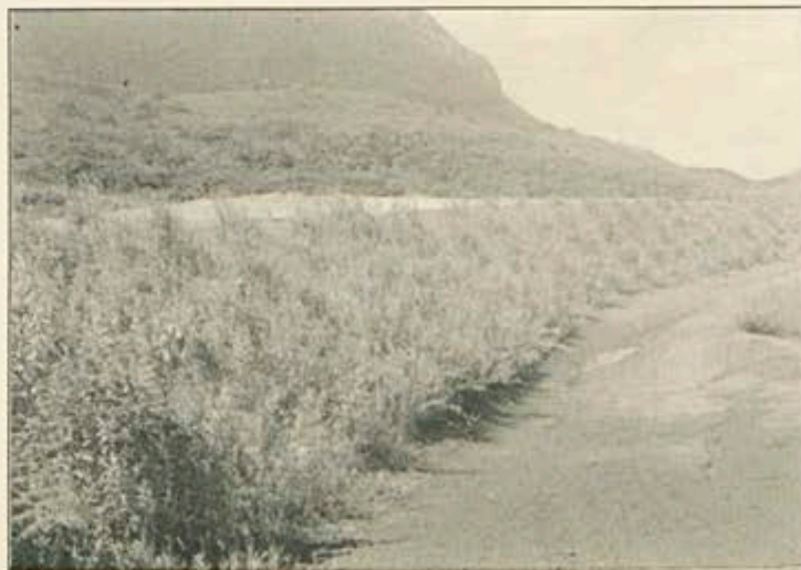
Revegetação se desenvolvendo nos taludes
