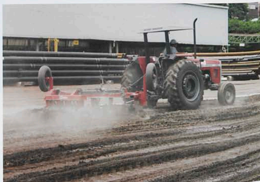
Aplicação do RBI Grade 81 no pátio da V & M Florestal, em Belo Horizonte (MG).
