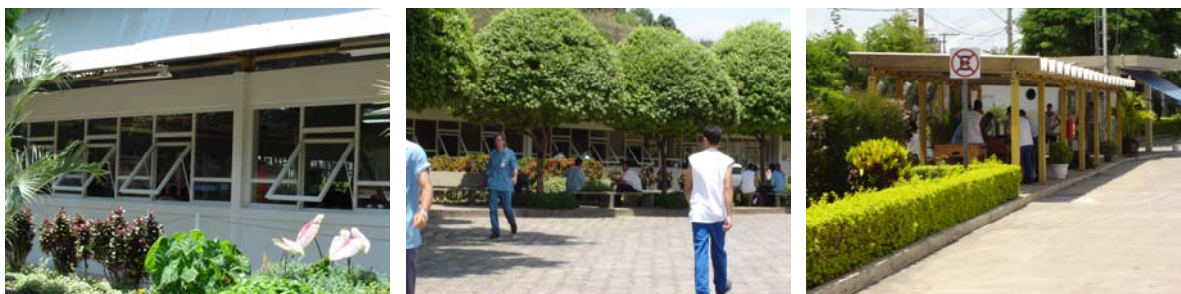
Figura 15 - Refeitório, área p/ descanso e lazer.
