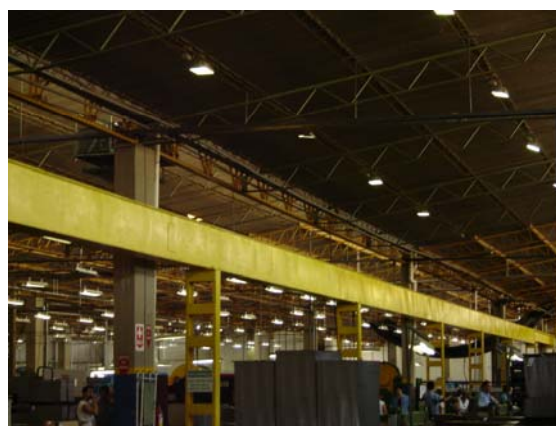
Figura 39 - Lâmpadas vapor de mercúrio.
