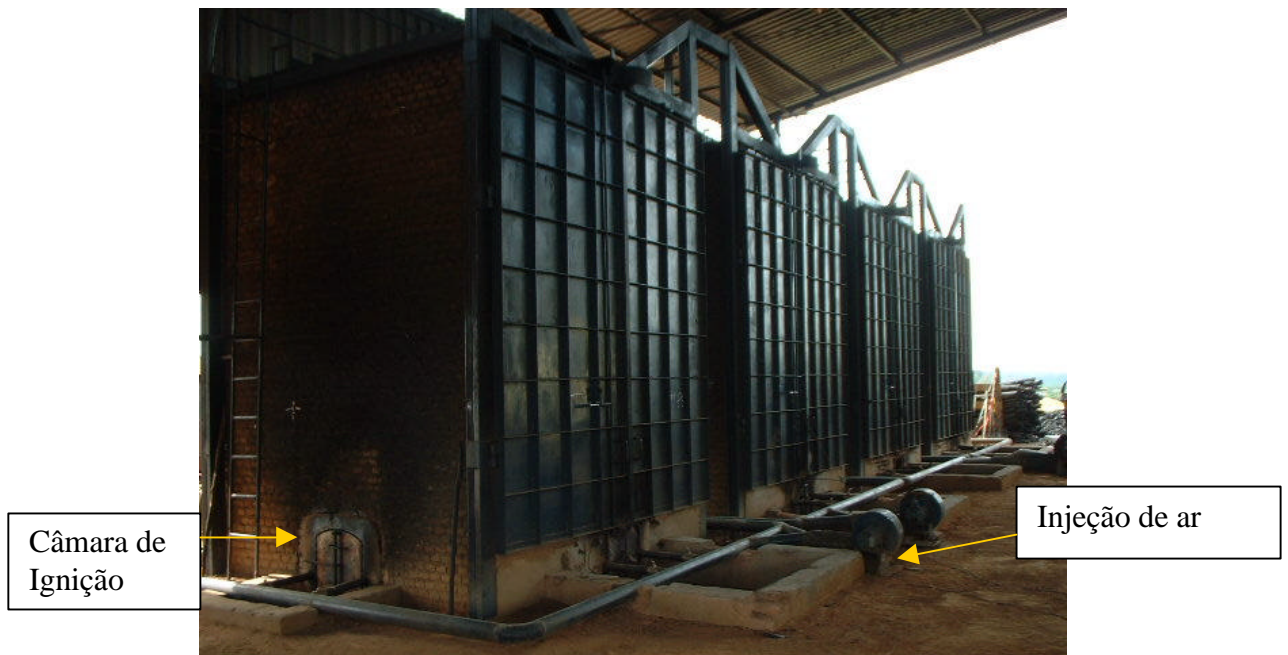
Figura 1 – Vista dos poços isolantes, câmara de ignição e do sistema de injeção de ar.
