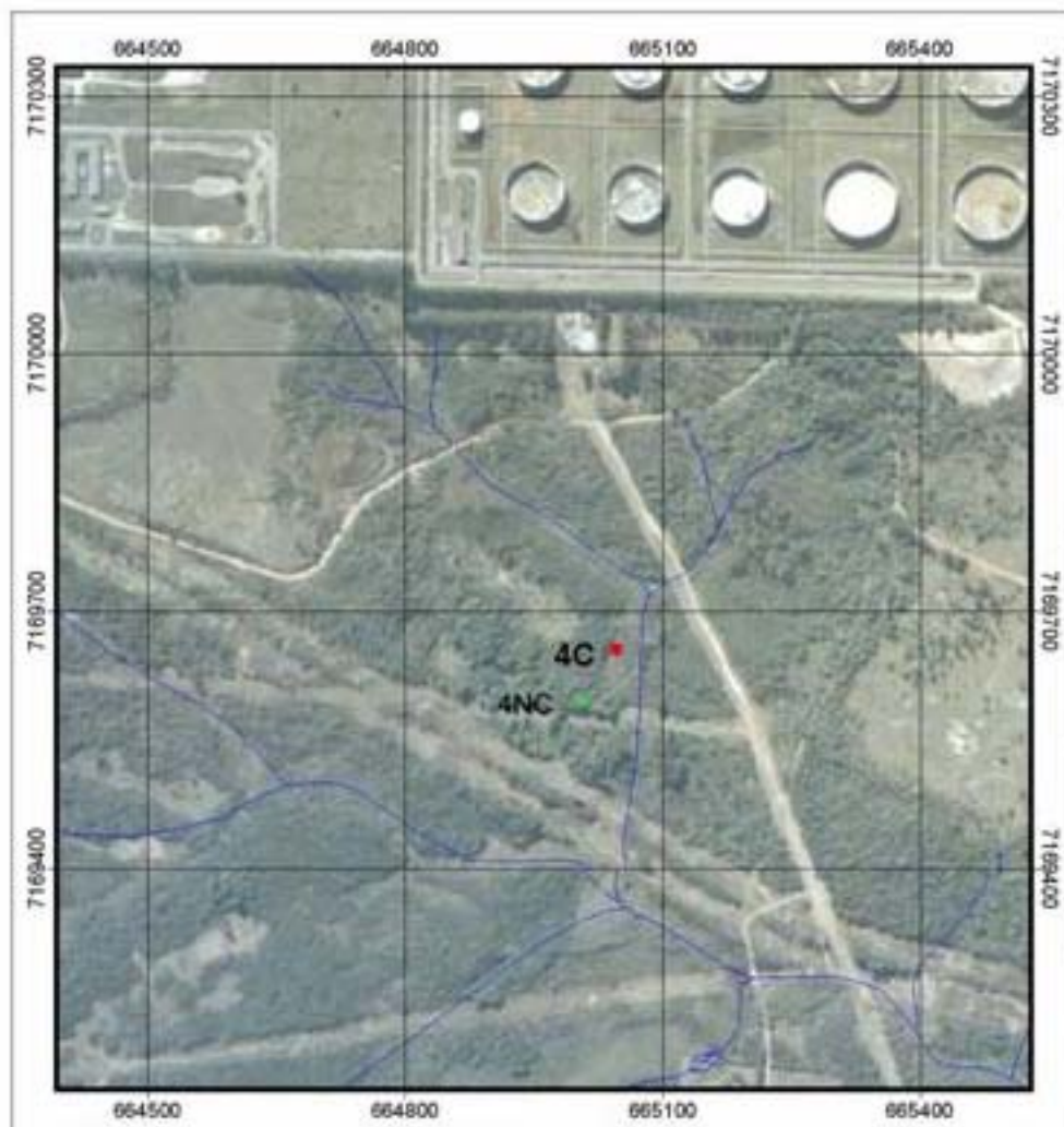
3- Foto aérea da área da Refinaria Presidente Getúlio Vargas - Araucária Paraná, onde foi coletado o solo não contaminado (4NC) e contaminado com petróleo (4C). Escala 1; 15000; fonte UFPR.
