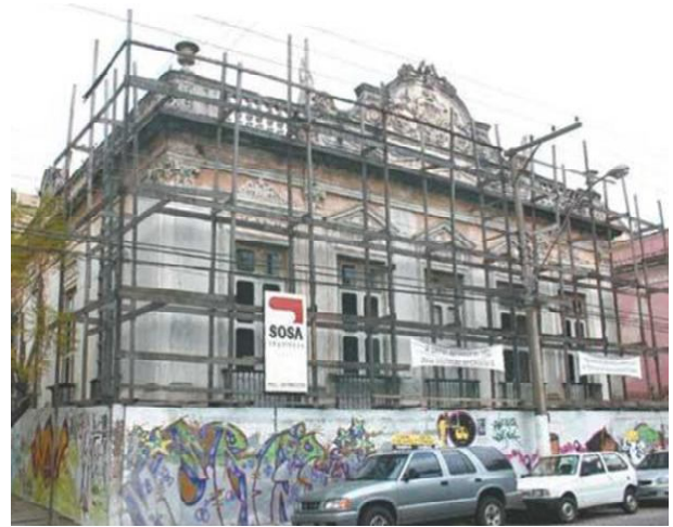
Figura 1 – Local de estudo: prédio histórico da cidade de Pelotas, RS.
