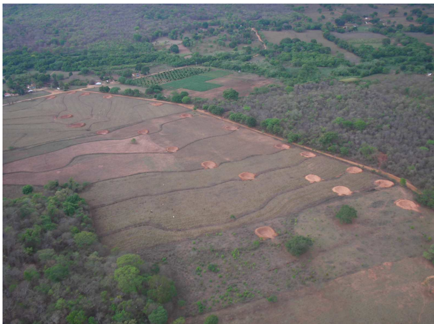
Figura 3 Construção de barraginhas e terraços na bacia do rio dos Cochós. Fonte: Projeto Plantando água
